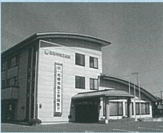
【工事期間】 令和2年 10月～12月
